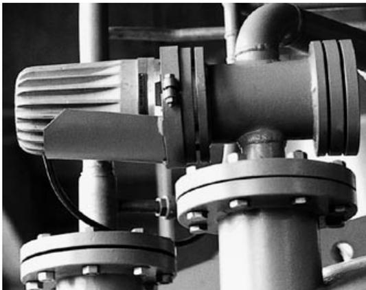
Proiettore CHEMLUX®, tipo L 20 deH M sp, 20 W, 24 V, Ex d e IIC T5 Gb, Ex t IIIC T95°C Db IP67, Ex II 2 G + D, con vetro opalizzato «M», montato su una spia visiva
